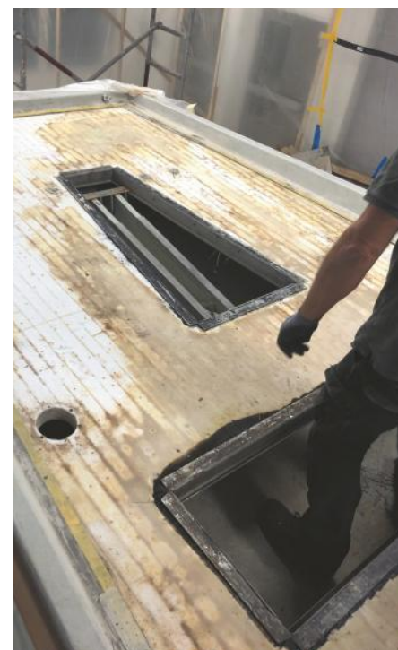
Der alte Deckbelag ist weg.
