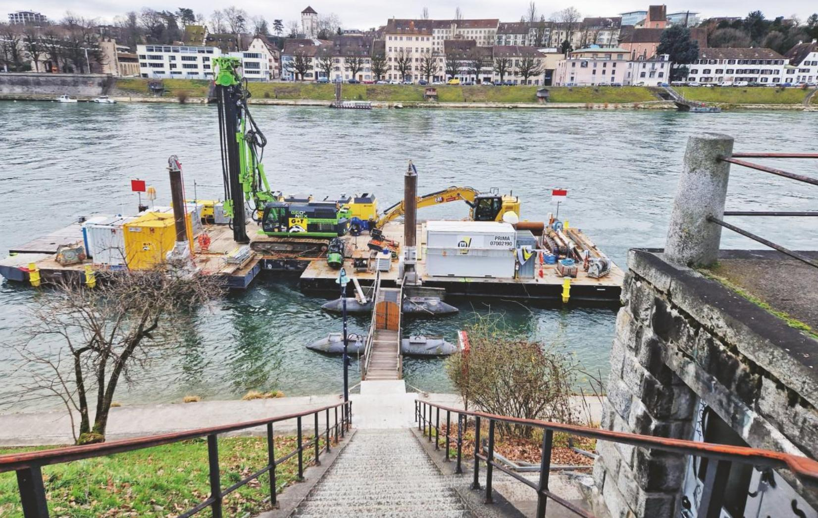
Ein weiteres Bild von den Bauarbeiten für den neuen Steg der St. Alban-Fähre. Hier die Installation zum Rammen der beiden Dalben.
